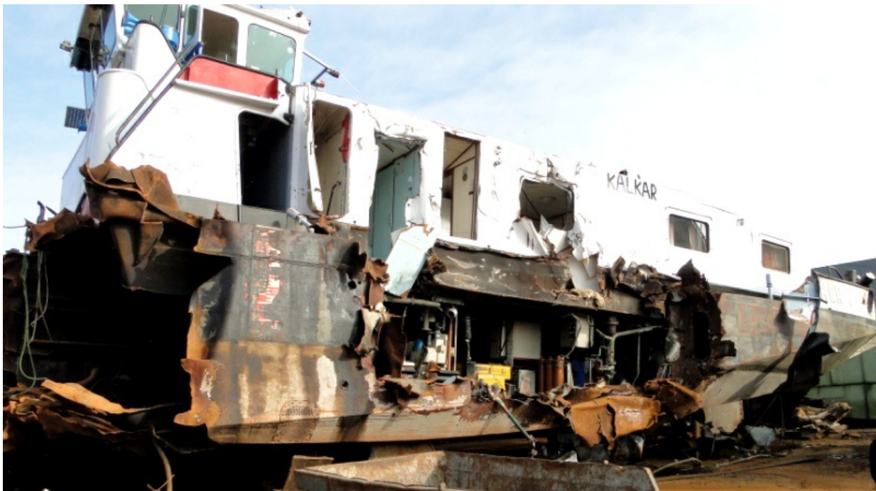
A parte das cabines também é inteiramente desmontada
